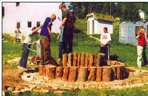
Urtespiral under bygging
